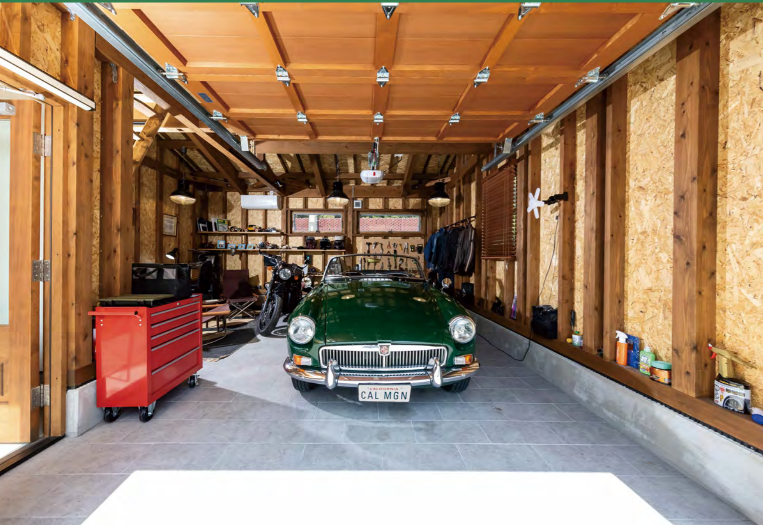
ガレージは外断熱仕様になっており、内壁は躯体の現し仕上げになっている。無骨なディテールがMG-Bやトライアンフ・ボンネビルの持つ世界観とよくマッチしている。
